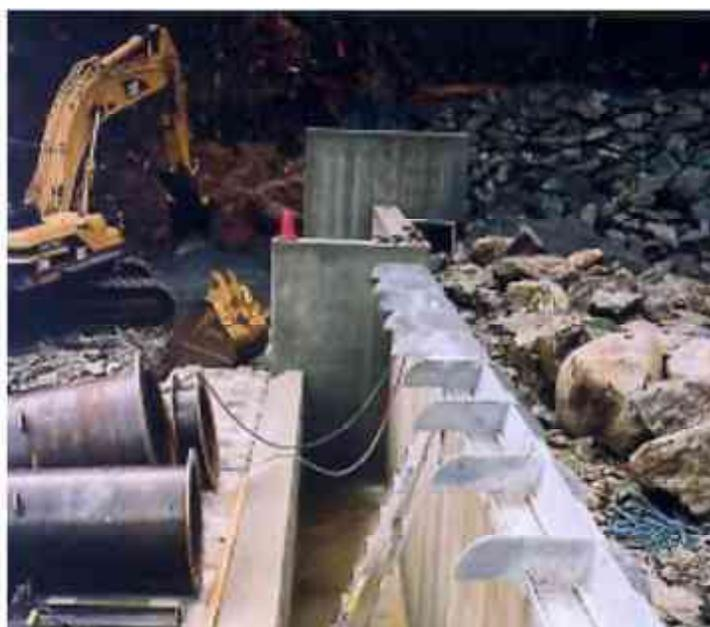
Il canale sarà sormontato da due griglie sovrapposte per il filtraggio delle acque da condurre in Centrale. Una griglia sottostante, ad elementi molto ravvicinati e posti trasversalmente rispetto alla corrente, vedi foto seguente e Figura 5,
