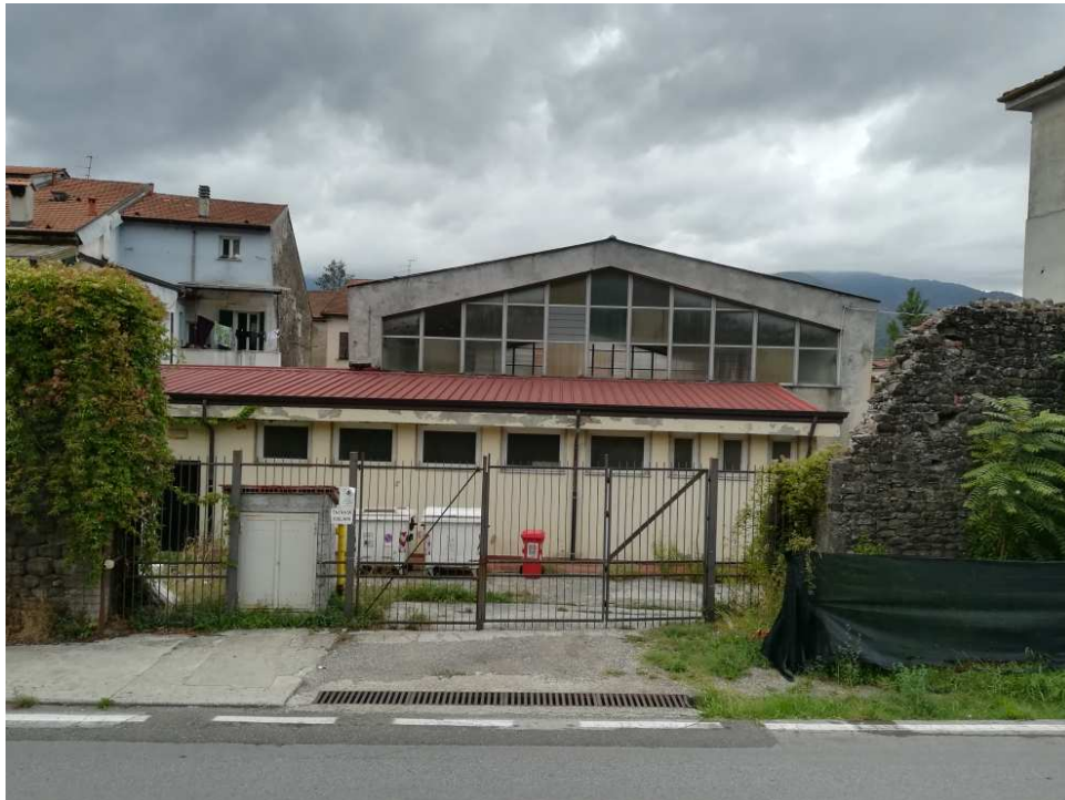
2 - Vista dell'edificio dalla Strada Statale
