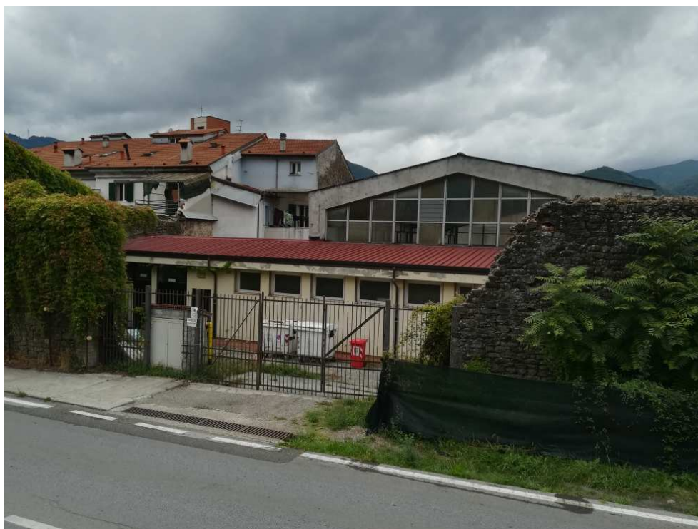
1 - Vista dell'edificio dalla Strada Statale
