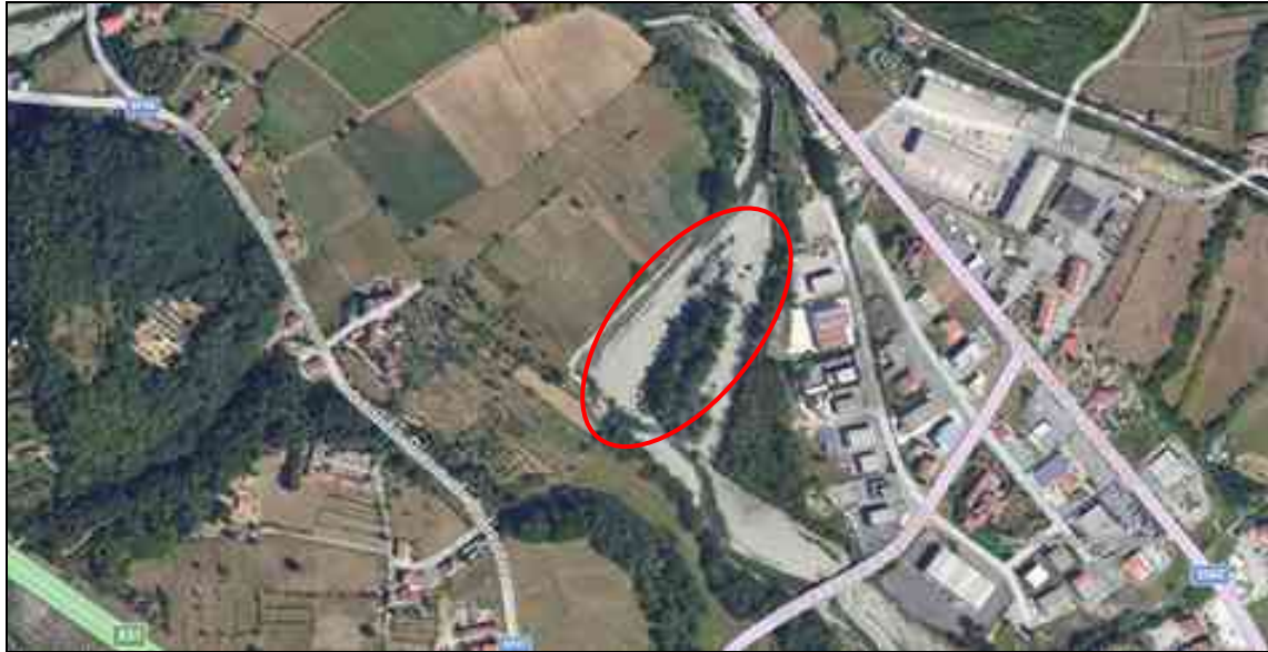
Figura 35 –Zona di erosione in destra idraulica
