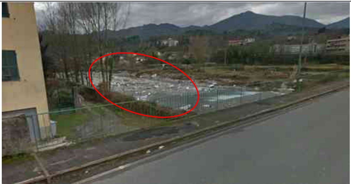
Figura 18 –Muri allo stato attuale, rispettivamente a monte e a valle del ponte Alcide de Gasperi
